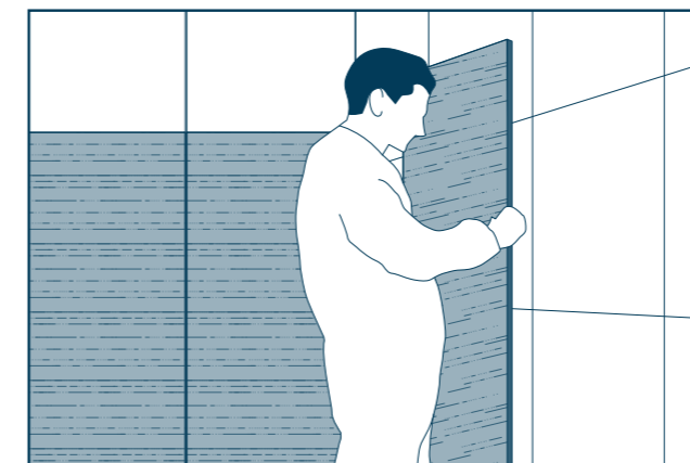
13 | Auflegen einer Schutzplatte auf den verlegten Wandbelag
