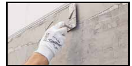
Positionierung des Profils mit Versenkung des Netzes
