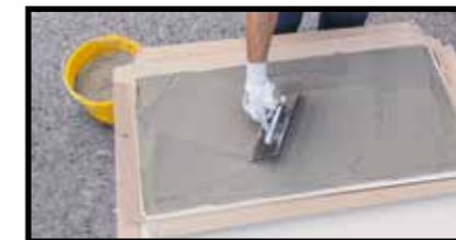
Doppelte Auftragung (Rückseite SLIMTECH)
