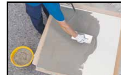
Doppelte Auftragung (Rückseite SLIMTECH)
