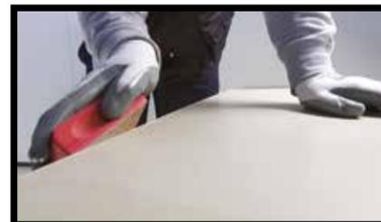
**Abb.12** - Die Versäuberung der Kanten kann manuell mit Diamantschwämmen oder Schleifpapier erfolgen. Mit einem leichten Schleifvorgang auf der Platten-seite kann eine Stumpfschliffwirkung und mit wiederholten Durchgängen eine abge-schrägte Wirkung erzielt werden.
