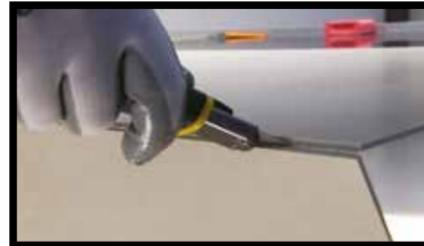
**Abb.4** - Bei SLIMTECH 3PLUS und SLIMTECH 5PLUS muss der Schnitt nach dem erfolgten Einkerbungen des Keramikteils und nach dem Trennen der Platte durch Einschneiden der Glasfaser mit einem normalen Cuttermesser vollendet werden.
