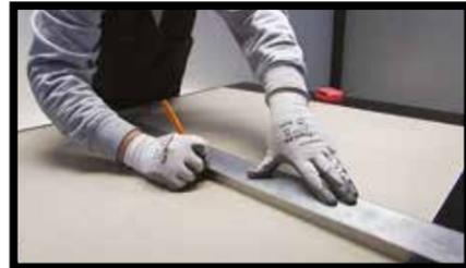
**Abb.2** - Für die Ausführung geradliniger Einkerbungen können die normalerweise von Maurern verwendeten Aluminium-Messlatten eingesetzt werden.
